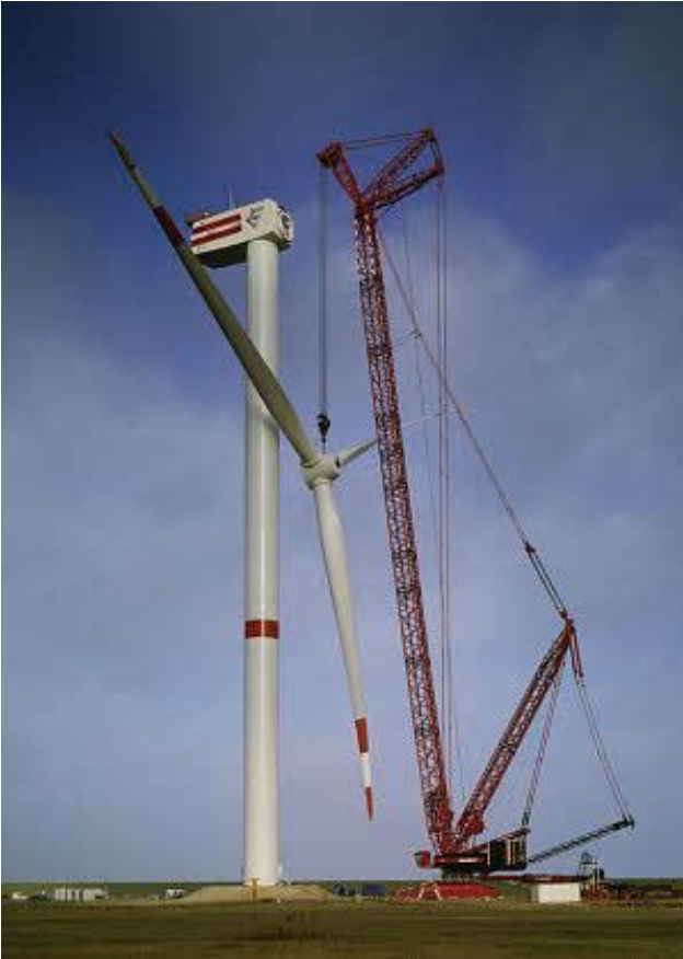
Montaggio di pale eoliche con gru derrick
